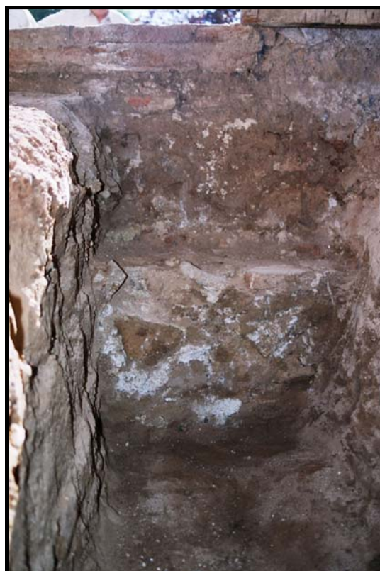
18.- Detall de la fonamentació del mur (UE25). Foto feta des del nord-oest.
