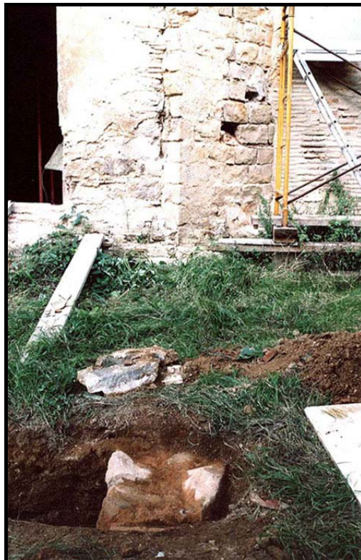
6.- Vista des del sud de la cala 2. S'observa la fonamentació del mur (UE7).
