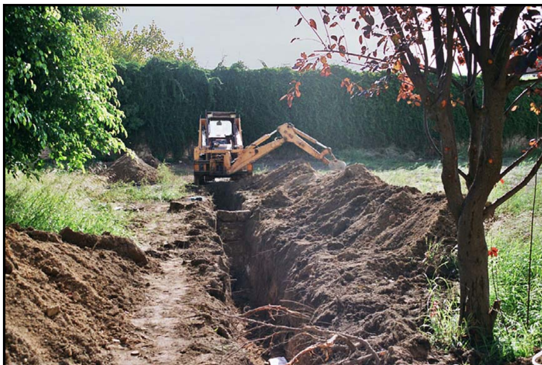
22.- Vista general des del nord-oest dels treballs d'excavació de la rasa 2( hort de les monges).
