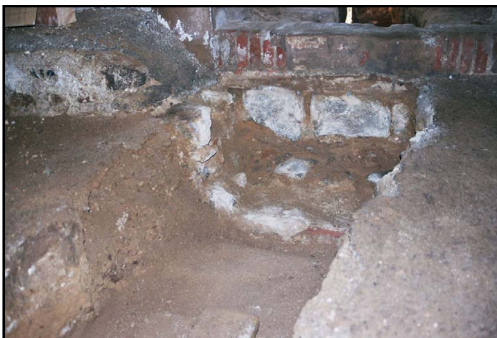
14.- Detall de la rasa 2. S'observa la fonamentació del mur de l'abadia (UE30), la fonamentació del banc (UE32) i la part inferior del llindar de la porta (UE31) que dóna accés a l'habitació 1. Foto feta des del nord-est.
